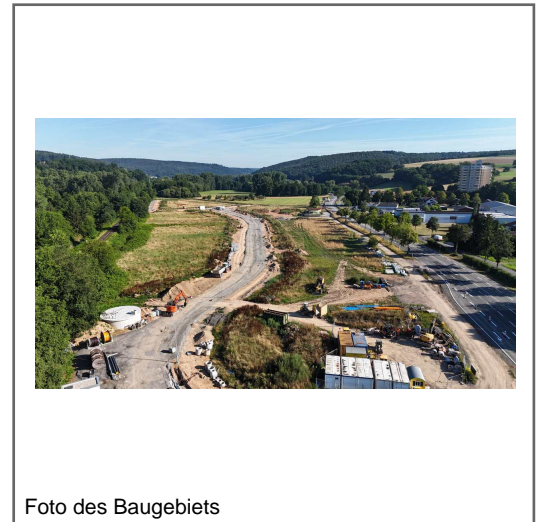
Foto oder Ma e des Bauplatzes
