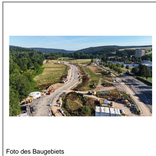
Foto oder Ma e des Bauplatzes
